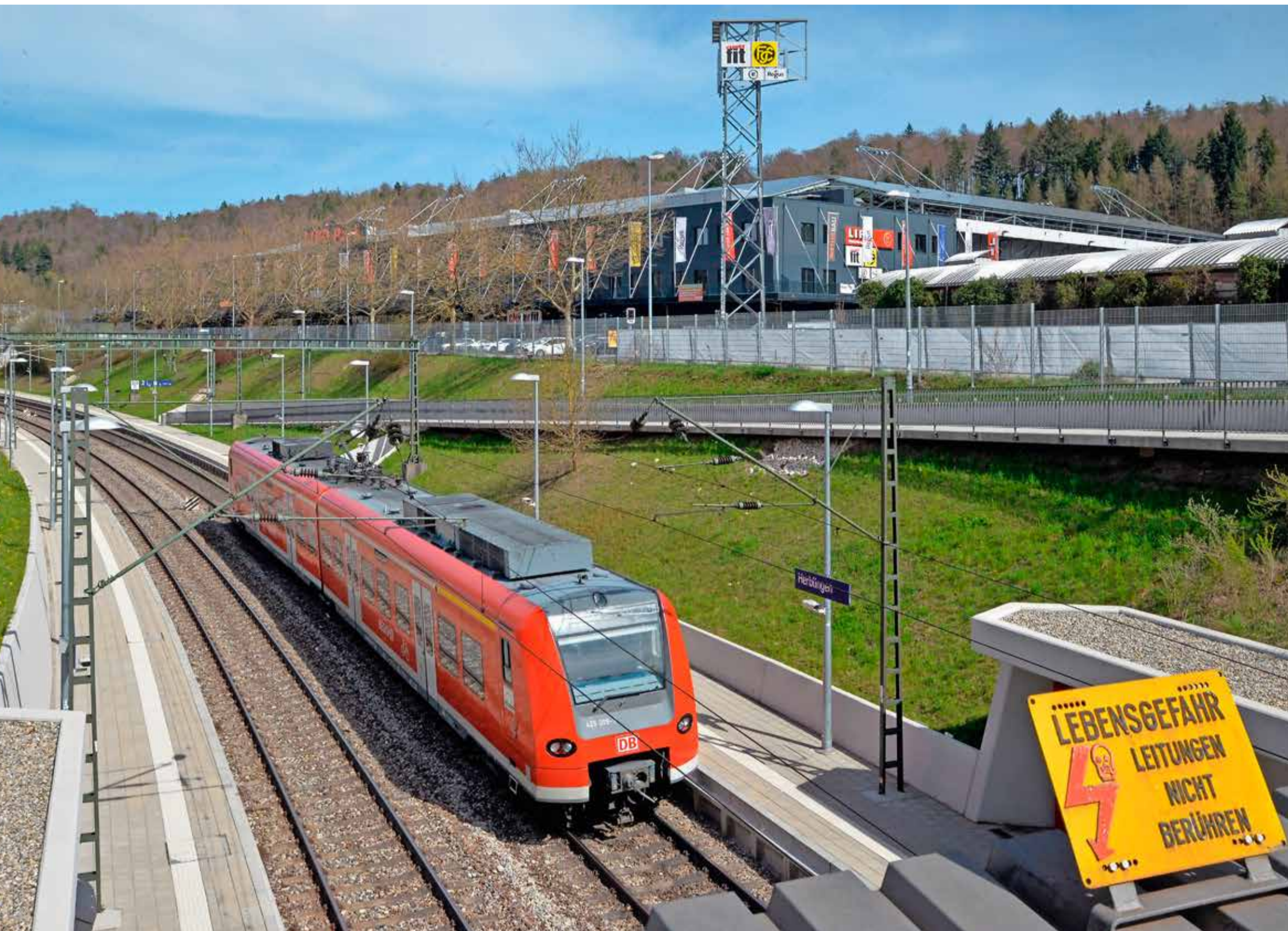
Der heutige Herblinger Bahnhof wurde Ende der 1960er-Jahre am Ende eines 530 Meter langen Tunnels erstellt. In Zusammenhang mit dem Bau des neuen Stadions waren Zugänge und Bahnsteige massiv erweitert worden. BILDER THEO KÜBLER
